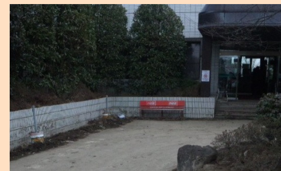
津波の引いた後の真壁病院 正面玄関前 泥や漂流物がまだ残る (3月15日午前10時頃撮影)
