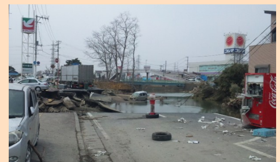
道路の落ちた国道45号線と 石巻大街道の交差点付近 大街道側より(3月20日撮影)
