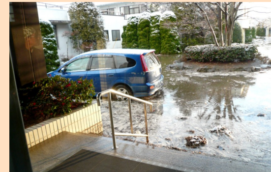
津波が押し寄せた真壁病院 正面玄関前 床下浸水に留まる (3月11日午後5時頃撮影)
